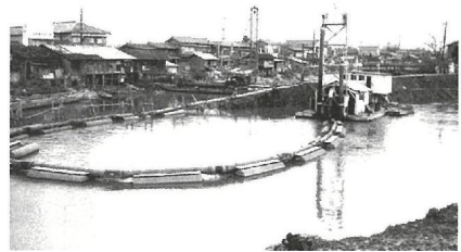
1964（昭和39）年頃の改修工事のようす
