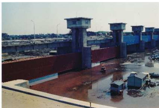
昭和46年 工事中的新潟大堰（当館所蔵）
