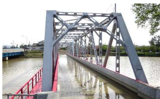
現在の西川水路橋
