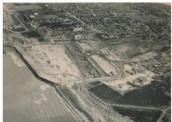
昭和43年 開削工事の様子（当館所蔵）
