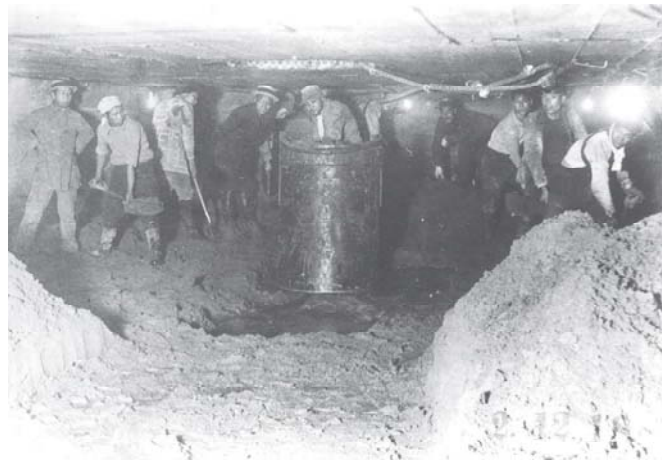
写真1 潜函内部の作業
