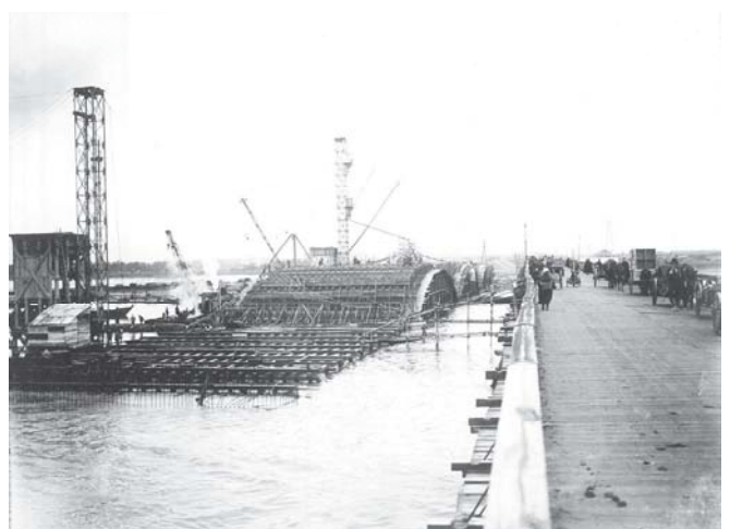
写真3 工事が進む3代目萬代橋（左）と2代目萬代橋（右） （手前が新潟側）
