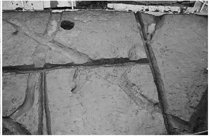
1区 SD47・48・51（Ⅰb期）完掘状況（西→東）
