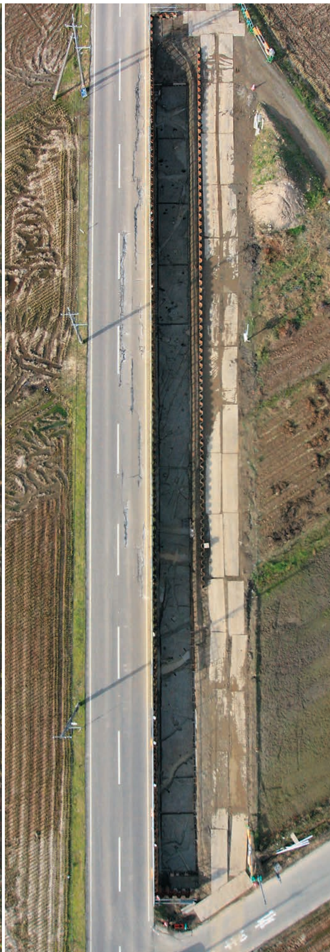
2区全景空中写真
