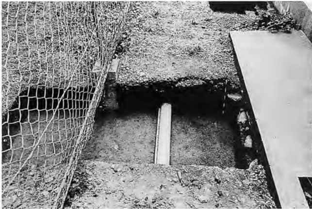
2 1T土層断面 (南西から)
