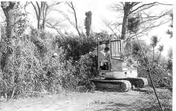
30 観音原遺跡調査風景(神社境内、8 T)
