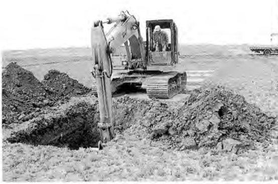
1 (仮称)新潟国際情報大学予定地調査風景
