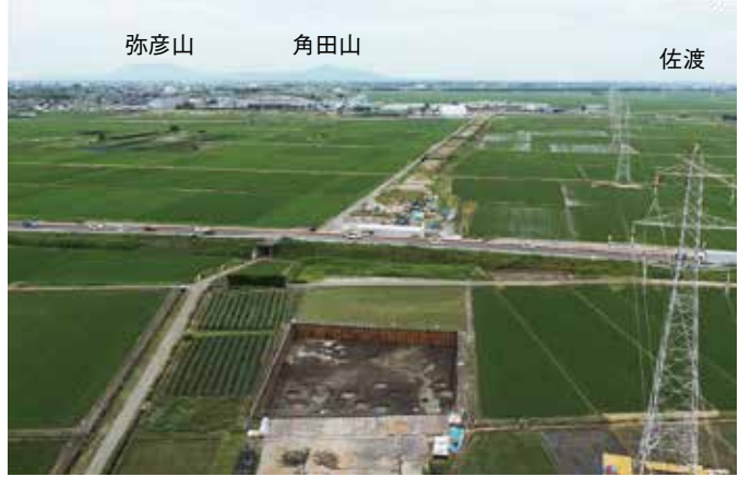
調査後の様子（6月下旬・東から）
