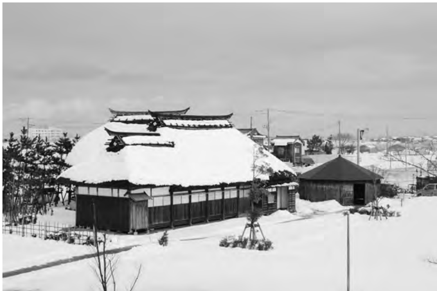
市指定文化財旧武田家住宅及び畜動舎外観
