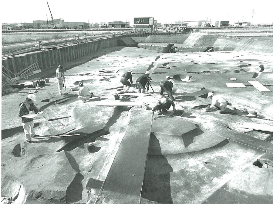
調査のようす(大型の竪穴建物)
