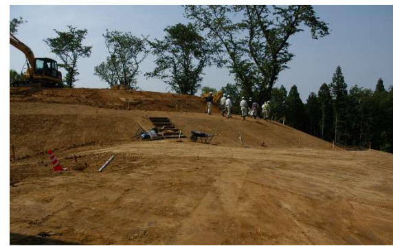
古津八幡山古墳復元整備工事のようす（2014 年）
