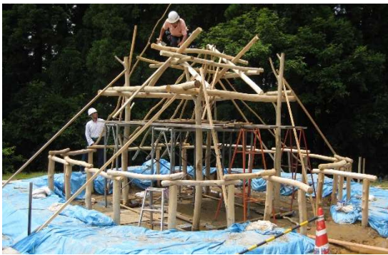
古津八幡山遺跡復元整備工事のようす（2009 年）
