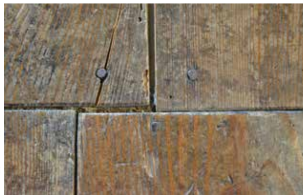
写真10 前座敷2階次の間床板における和釘と洋釘
