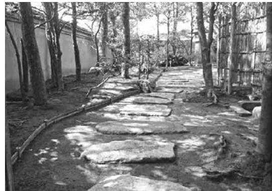
中庭堆積土除去・土留め柵設置②
