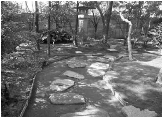
中庭堆積土除去・土留め柵設置①
