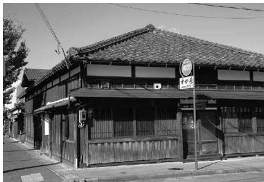
旧片桐家住宅 主屋外観（南東から）
