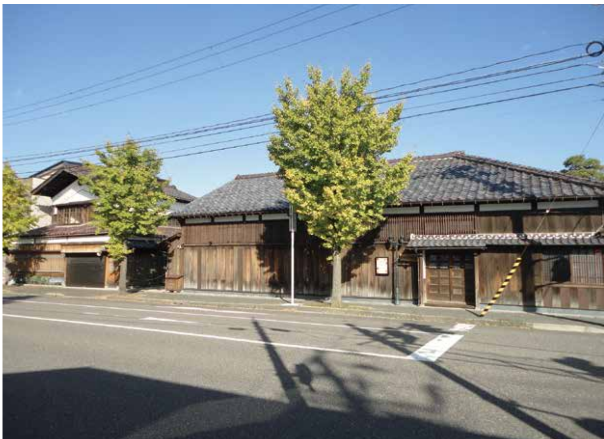
国登録有形文化財に新規登録された旧片桐家住宅 主屋・土蔵外観（南東から）
