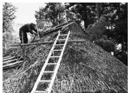
復元竪穴住居の茅葺屋根 葺き替え作業風景
