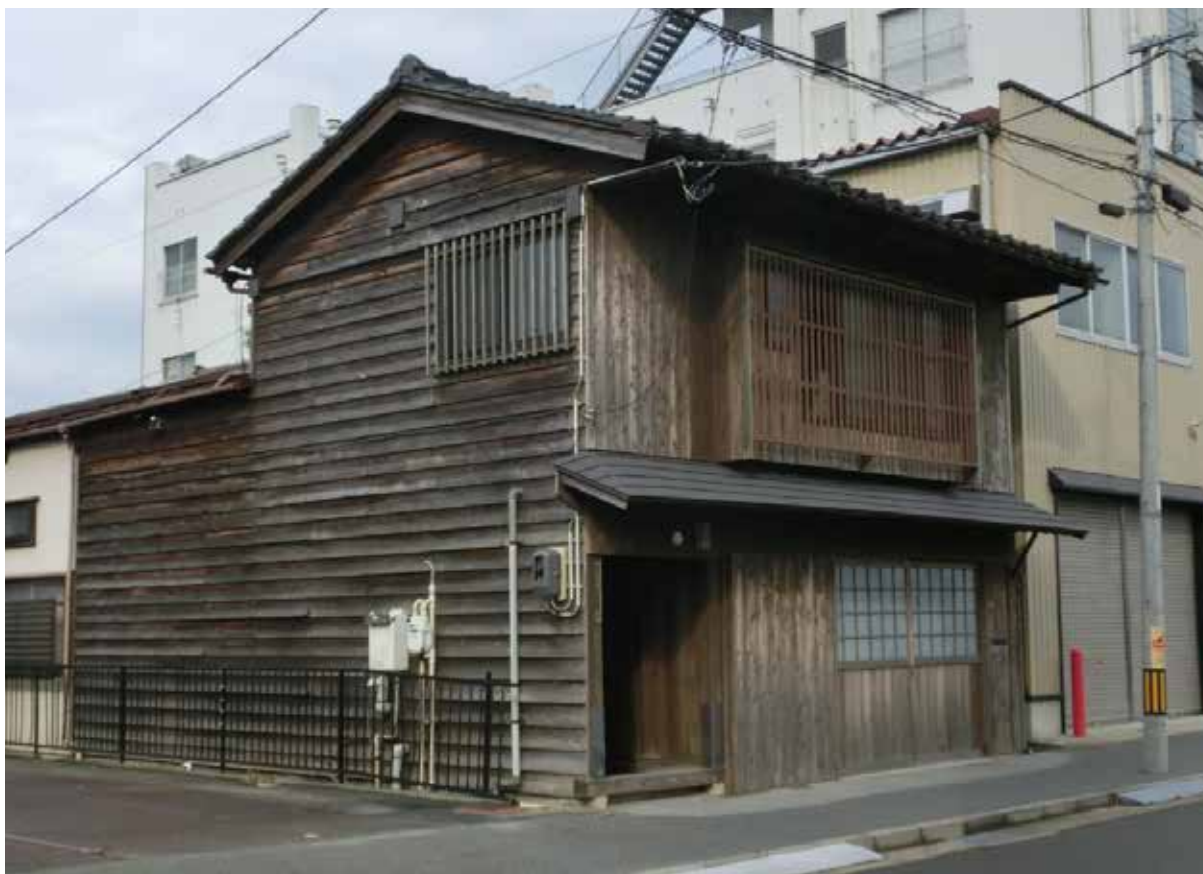
新規登録された高須家住宅 主屋外観（南東から）
