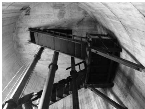
旧白根配水塔 2階内部
