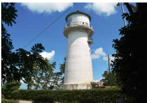
新登録された「旧白根配水塔」
