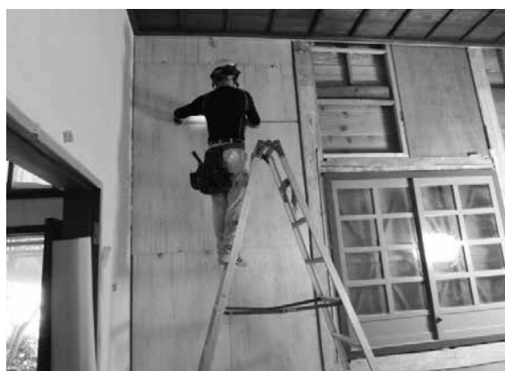
壁内部への構造用補強合板の打ち付け作業
