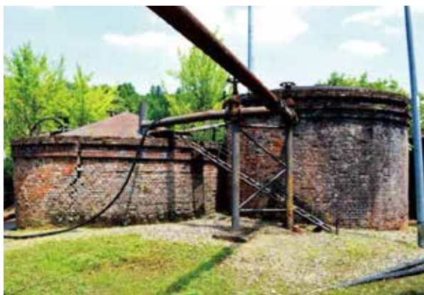
新指定された「新津油田金津鉱場跡」の計量タンク
