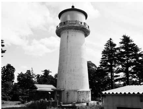
旧白根配水塔 外観全景
