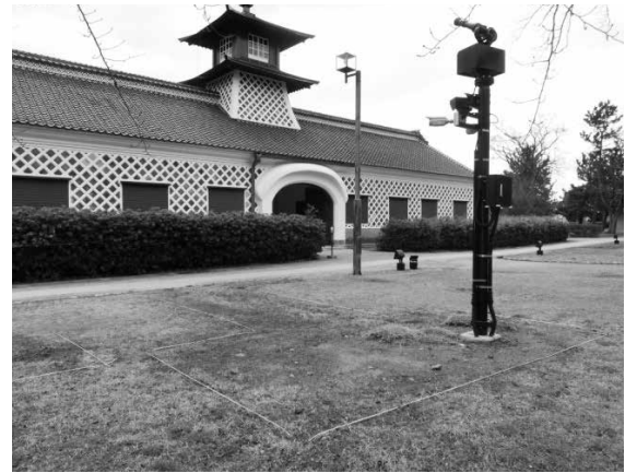
東側の放水銃（監視カメラと炎検知器をポールに設置）
