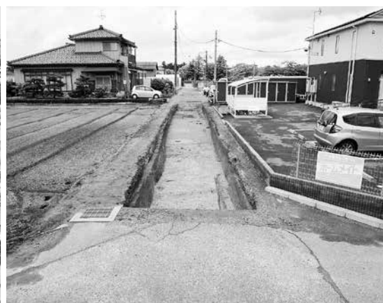
完掘全景 南東から（写真奥が砂丘頂部）
