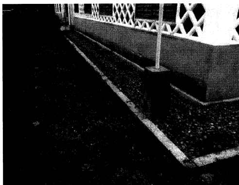
外構東面（着手前）
