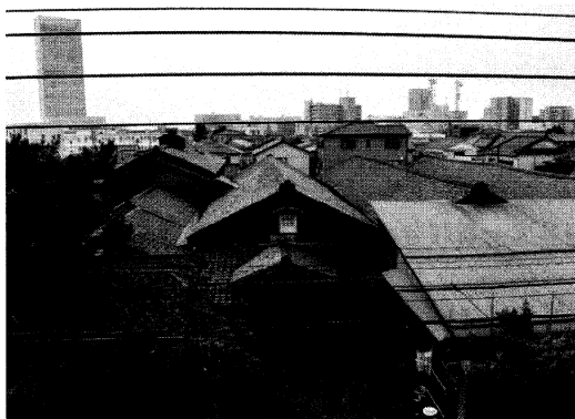
石山味噌醤油(株) 正面二号蔵、右側三号蔵、 右端五号蔵（平成27年4月）
