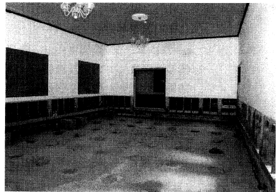
大広間(耐圧版打設・束石据え直し・床下固定竣工後)
