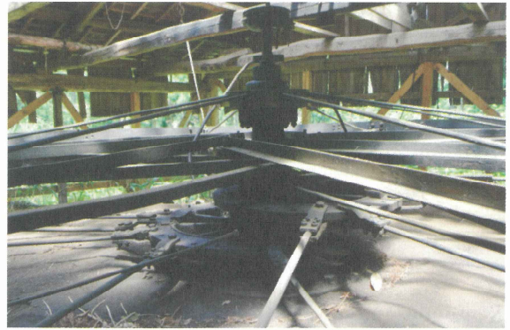
金津鉱場ポンピングパワーユニット
