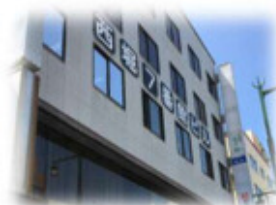
施設外観写真
