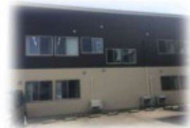
施設外観写真
