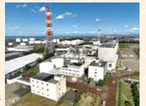
東北電力新潟火力発電所
