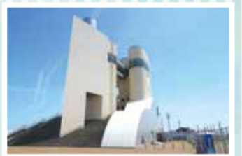
山の下みなとタワー
