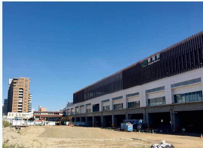
工事が進む新潟駅新万代広場
