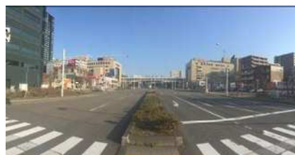
無電柱化された道路
