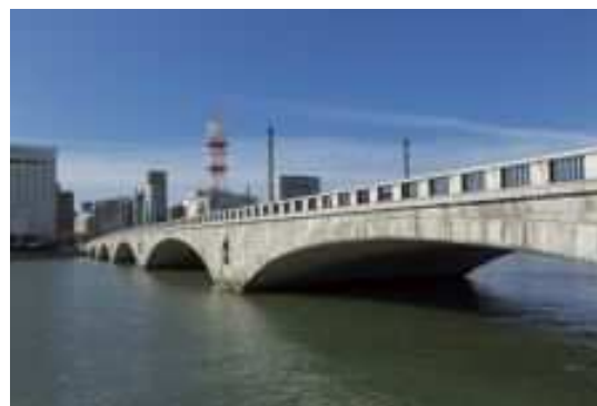
重要文化財萬代橋
