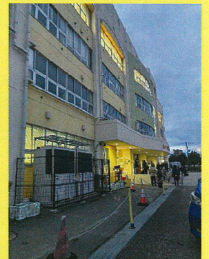
2024年1月1日に開設された津波避難ビルである鳥屋野小学校
