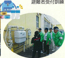
学校施設設備の確認
