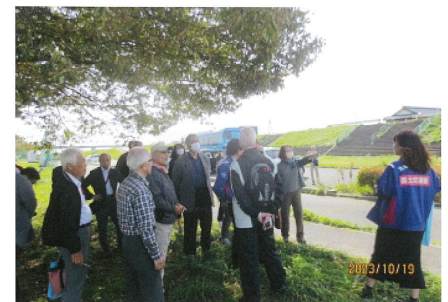
阿賀野川左岸堤防
