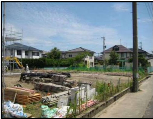
【写真⑰】店舗南側
