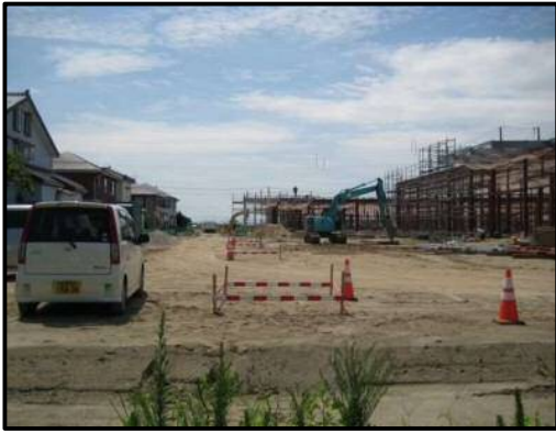
【写真⑳】 店舗北東側
