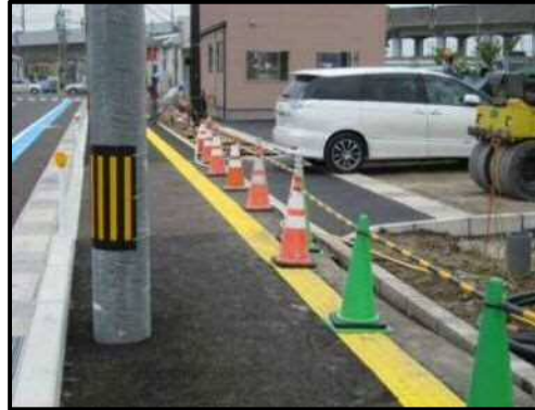
【写真 13】自動車（来客用）出入口 2
