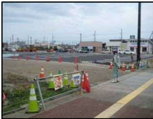
【写真 11】自動車（来客用）出入口 1
