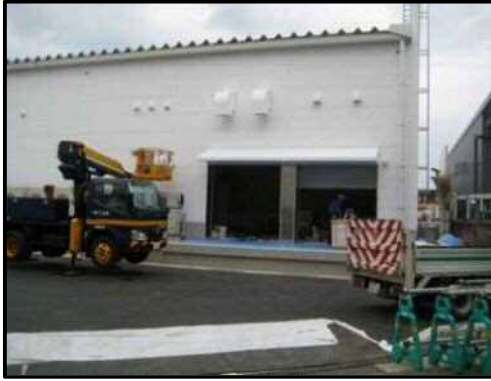
【写真17】荷さばき施設2
