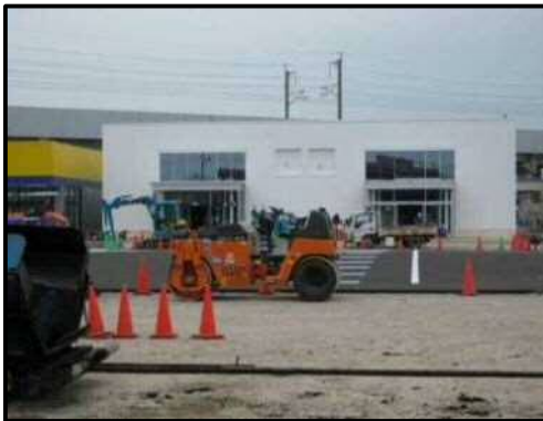
【写真23】ユニクロ棟
