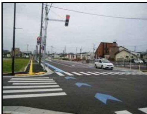
【写真 15】店舗北西側信号（新設）
