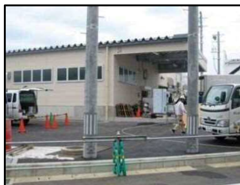
【写真 16】荷さばき施設 1
