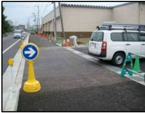
【写真 9】搬入車両出入口
