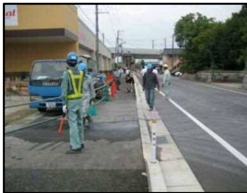
【写真8】店舗西側道路 (北→南)
