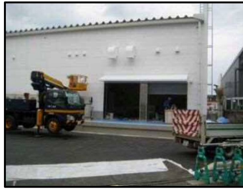
【写真 10】搬入車両出入口
