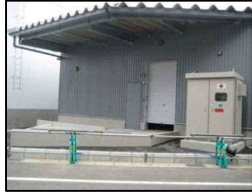
【写真18】荷さばき施設3
