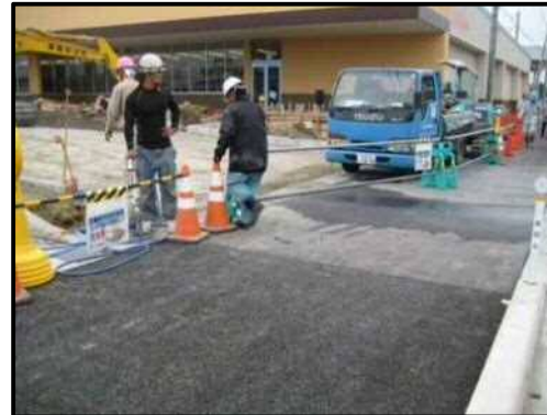
【写真 14】自動車（来客用）出入口 3
