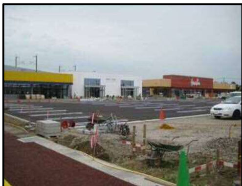
【写真1】店舗敷地
