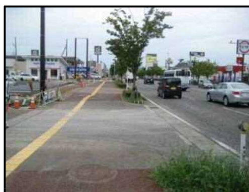
【写真3】店舗東側道路 (南→北)
