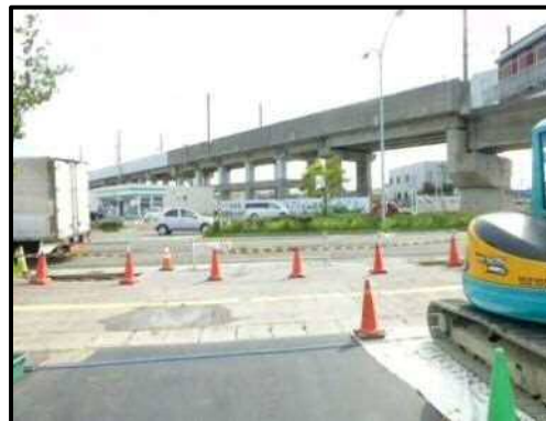
【写真 12】自動車（来客用）出入口 1 （店舗側から）
