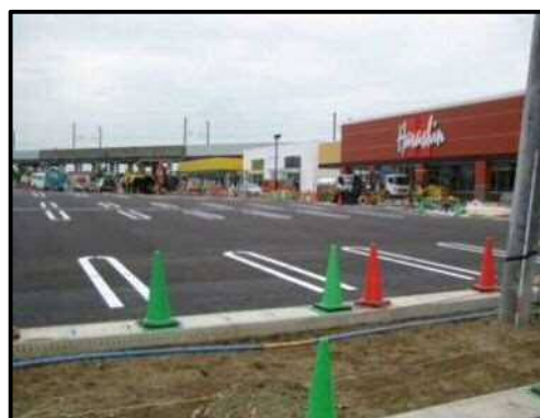
【写真2】店舗敷地2
