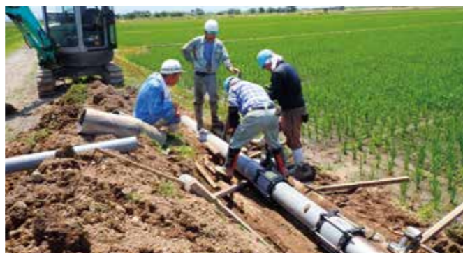
水路の漏水補修
