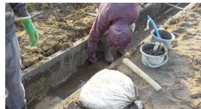
水路の軽微な補修
