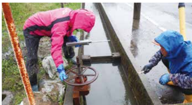
ゲートの保守管理
