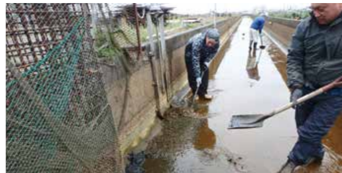
水路の泥上げ
