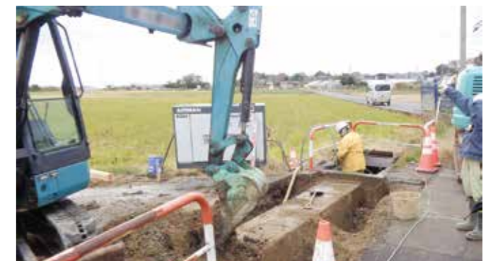
用水路横断BOXの更新
