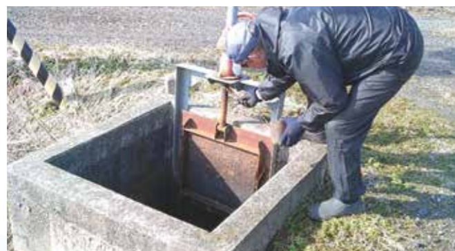
用水路ゲート点検、補修
