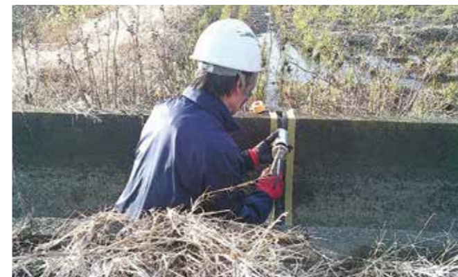
用水路の目地補修
