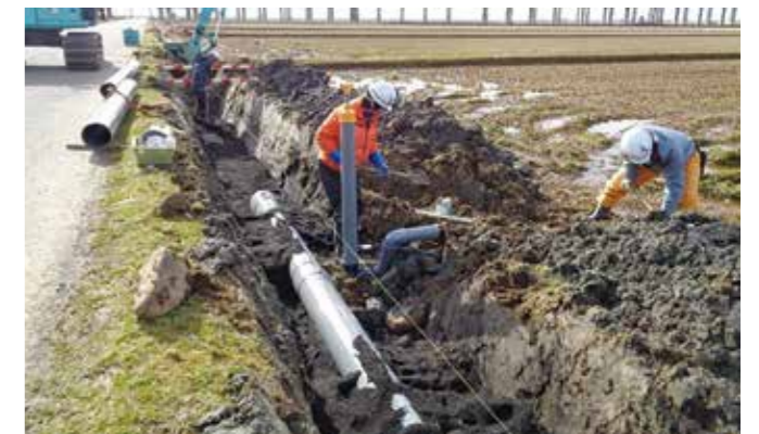
水路の補修、更新
