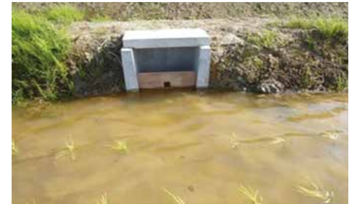
田んぼダム板の設置
