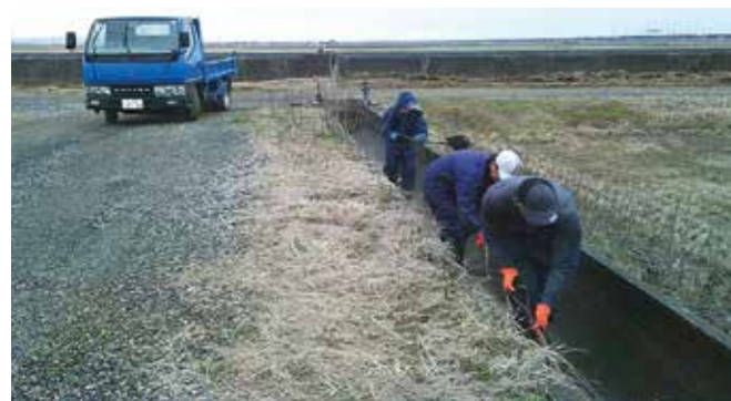
用水路の泥上げ
