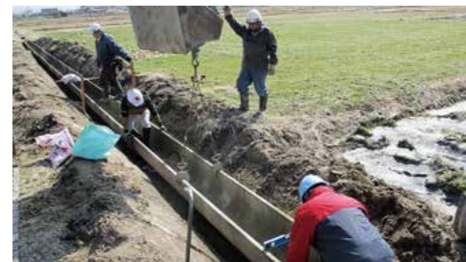
用水路の布設替え
