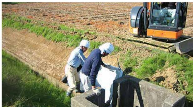
自主施工による水路法面のブロック張り（長寿命化）
