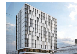
新潟駅万代口東地区開発 令和10年夏竣工予定
