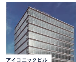
アイコニックビル 令和8年2月竣工予定
