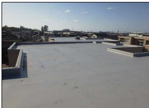
■屋上防水改修（施工前）
