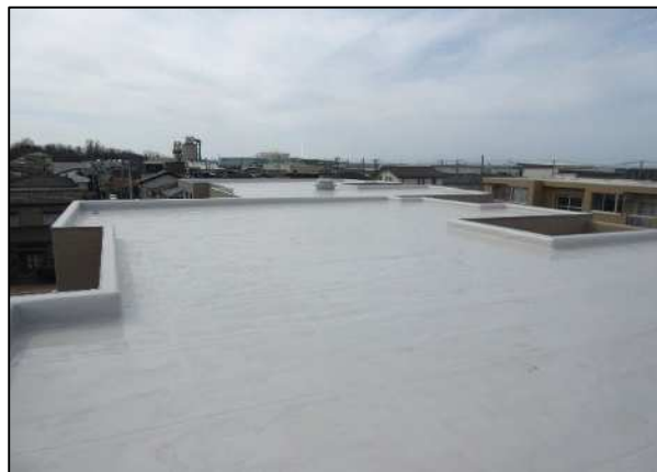
■屋上防水改修（竣工後）
