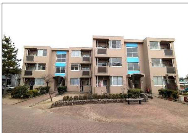
■外壁改修（竣工後）
