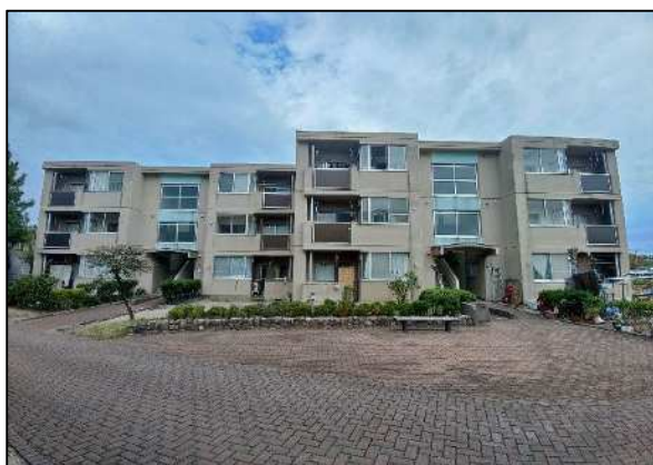
■外壁改修（施工前）
