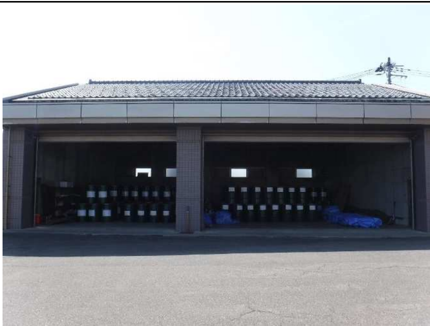
写真① 保管場所(全景)
