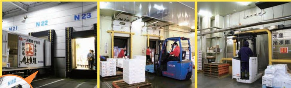
運ばれてきた品物は、温度帯ごとに保管し、品質を保ちます。冷蔵庫は5℃(C級)、-25℃(F級)、-50℃(超低温)という性能を持つ冷蔵保管庫があります。
