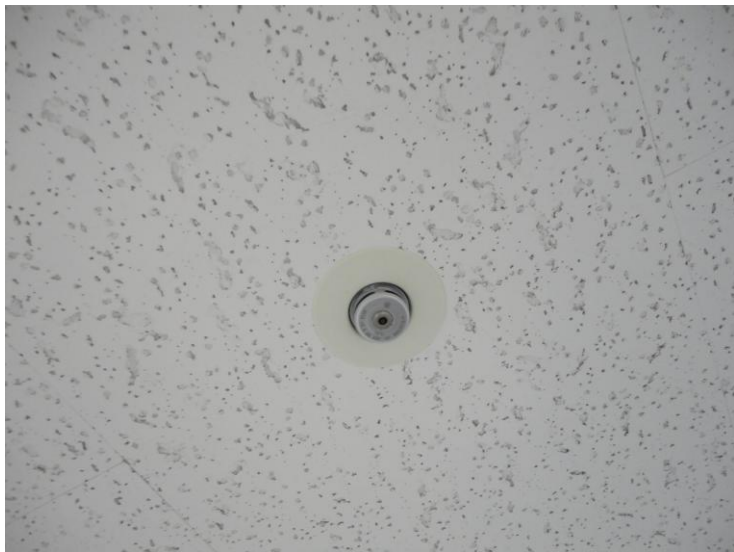
スプリンクラーヘッド（天井埋込形）
