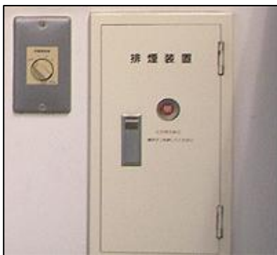
自然排煙における手動開放装置（オペレータ）
