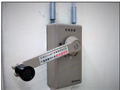
自然排煙における手動開放装置（オペレータ）
