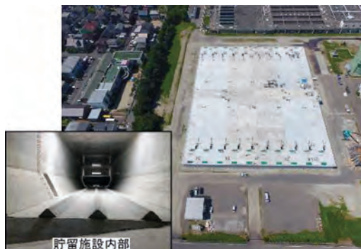
中部下水処理場 貯留施設
