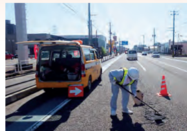
舗装補修の状況
