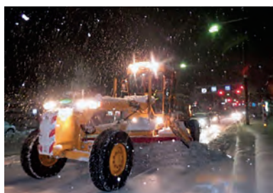
車道除雪の状況
