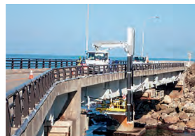
橋梁点検の状況
