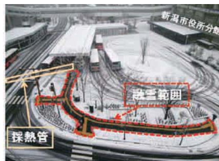
下水熱を利用した歩道融雪状況
