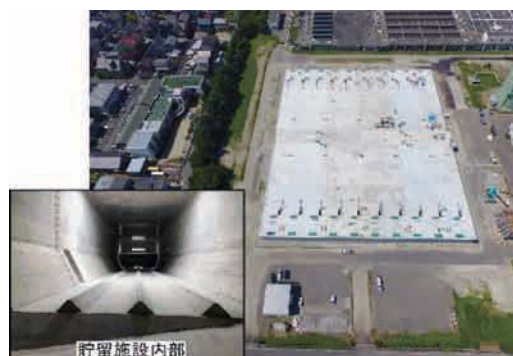
中部下水処理場 貯留施設
