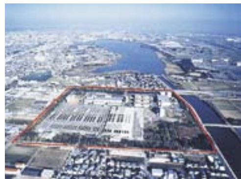
中部下水処理場
