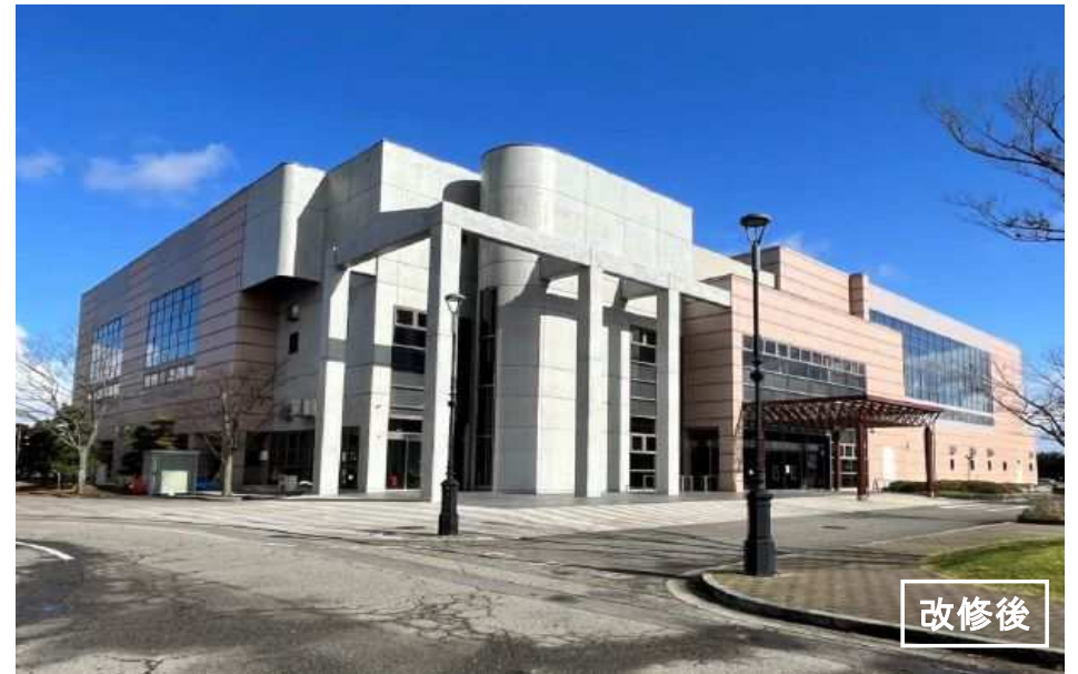
白根カルチャーセンター外壁改修工事
