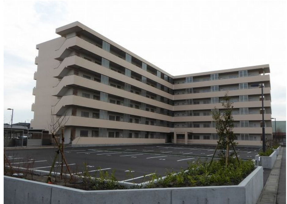
亀田向陽住宅
