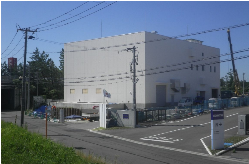
山田雨水ポンプ場(新築) 平成30年7月竣工
