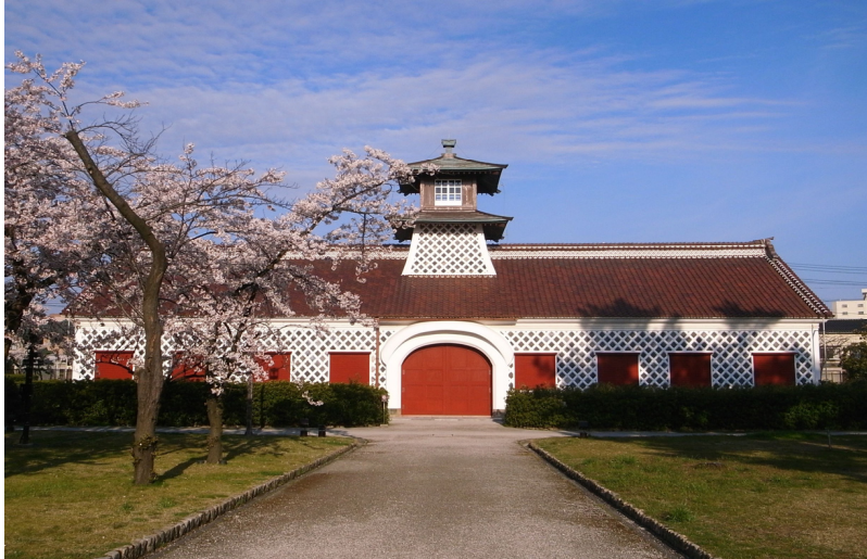
旧新潟税関庁舎(改修) 平成30年11月竣工
