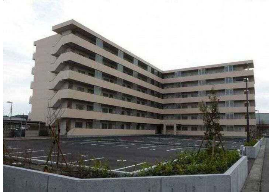
亀田向陽住宅
