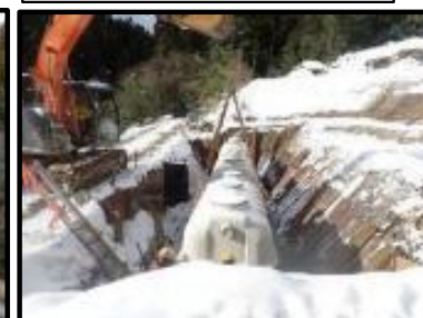
FRP製 油水分離槽 設置
