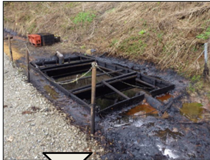
FRP製 油水分離槽 設置
