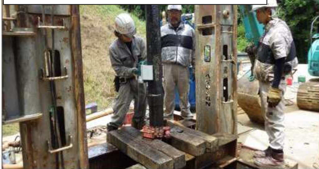
パイプを手動切断機にて切断 (5~6m/1本)
