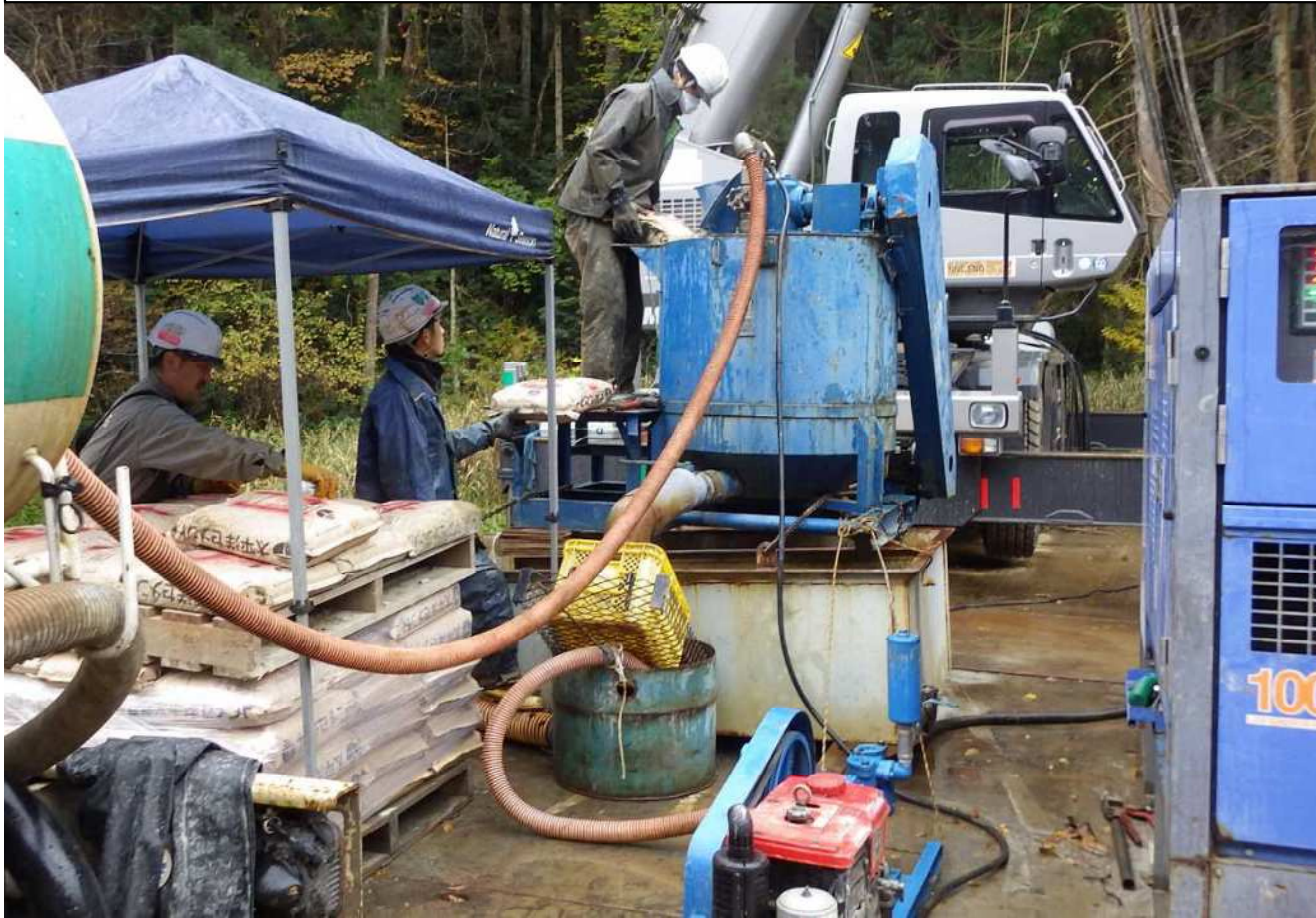
セメンチング作業 (セメントスラリー作液)
