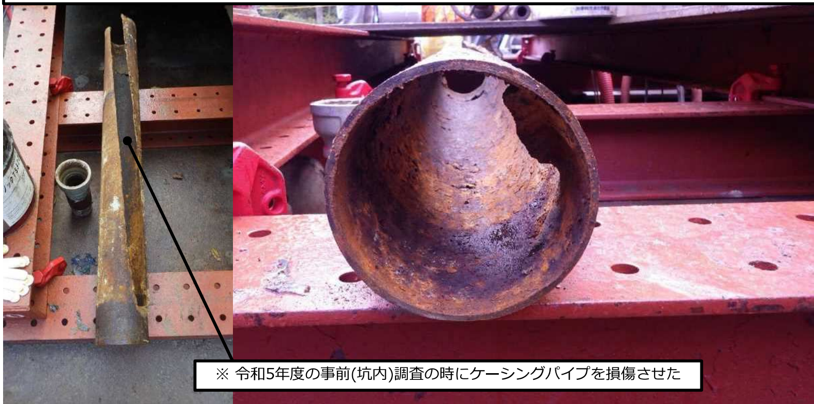
切断回収されたケーシングパイプ
