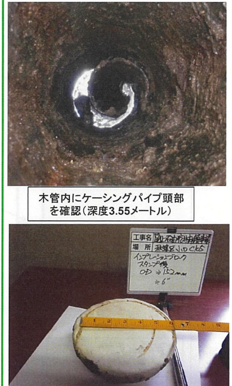
紙粘土製のインプレッションブロックにて、ケーシング頭部の外径が約6インチ(152.4mm)であることを確認
