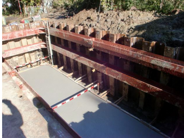
油水分離槽の設置
