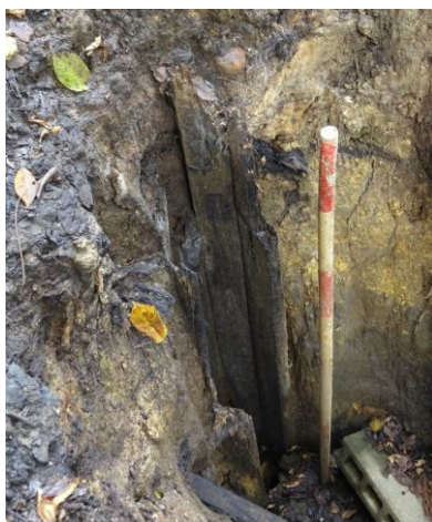
坑口部より最小内径20cmの八角形に組まれた木管が出現
