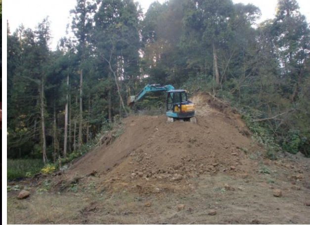
坑口部の整地
