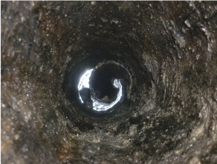
⑤木片を取り除いた後のケーシング頭部
