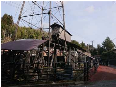
新津油田金津鉱場跡 C3号井
