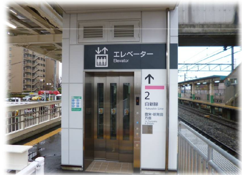
↑ エレベーター設置事例（東新潟駅）
