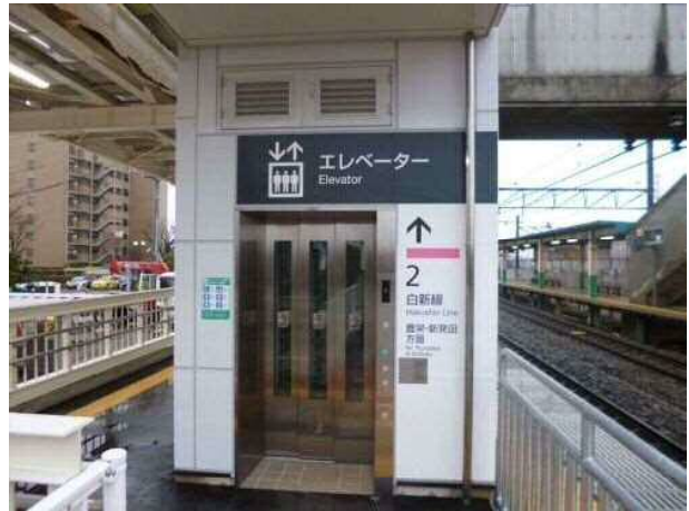
エレベーター設置（JR東新澁駅）
