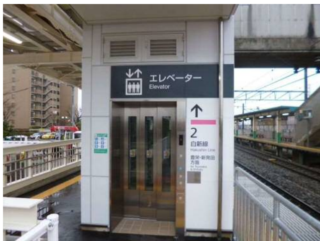
エレベーター設置（JR東新大塚駅）
