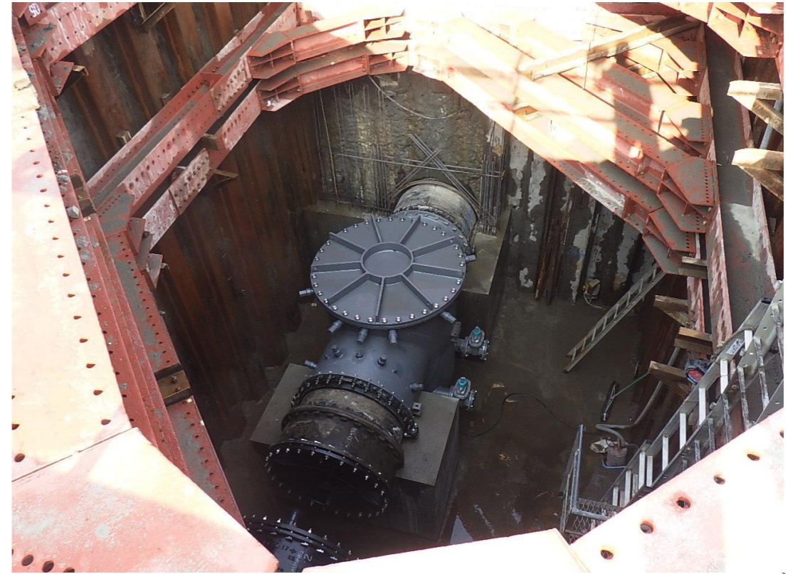
構内水管耐震化工事 不断水プラグφ1,350設置状況
