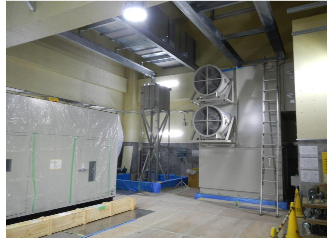
自家発電設備更新工事 ガスタービン他据付 (ポンプ場発電機室)
