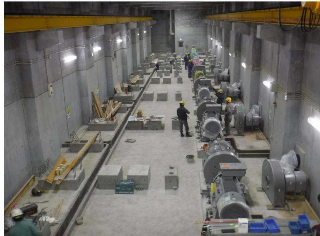
ポンプ設備更新工事 主ポンプ据付 (ポンプ場地下)
