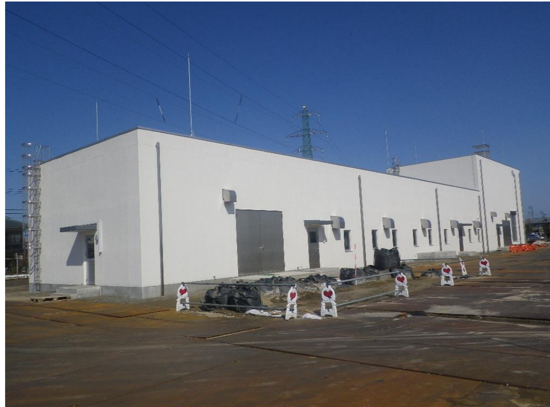
ポンプ場築造工事 平成30年1月完成
